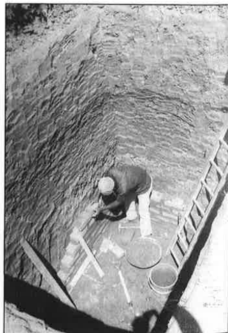
3 m djup grop som ska användas till avloppstank. Johanna murar väggarna.
