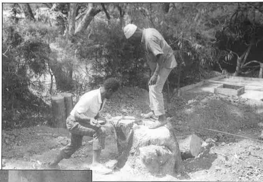
Bockning av armeringsjärn. Som hjälp användes en avkapad trädstubbe
