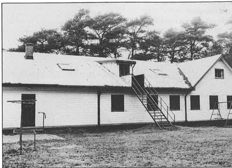
Här på annexets ovanvåning är det planerat att byggas lektionssalar. För att få så mycket plats som möjligt, skall en sk vindskupa byggas.
