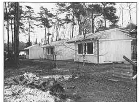
De nybyggda stugorna på Höllviksstrand.
