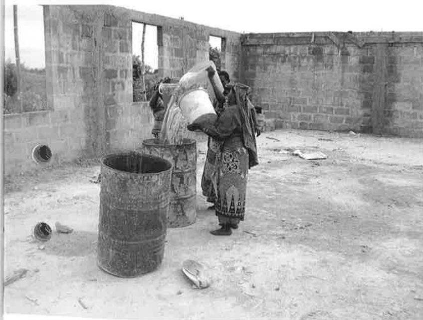
Vatten är ännu inte framdragit till arbetsplatsen. Till dess att vattenslangen har grävts ner har byggmästaren anställt tre kvinnor att mot betalning bära vatten. De hämtar vattnet i 20-liters hinkar, bär det på huvudet ungefär 300 meter och fyller stora oljefat och för detta får de en krona hinken.
