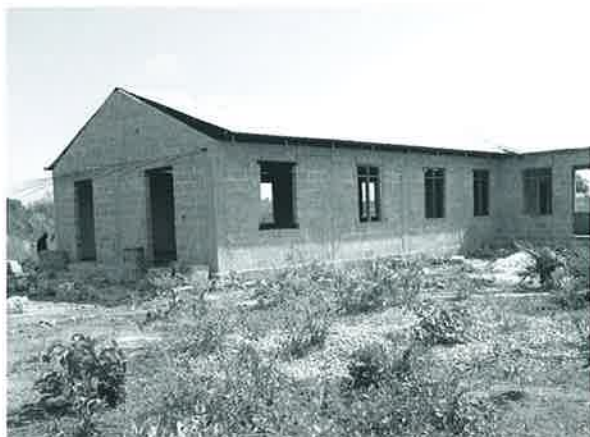
Den nya kyrkan är nästan färdig, återstår putsning och färdigställande av bl.a. tak, fönster och dörrar. All möblering invändigt återstår också.
